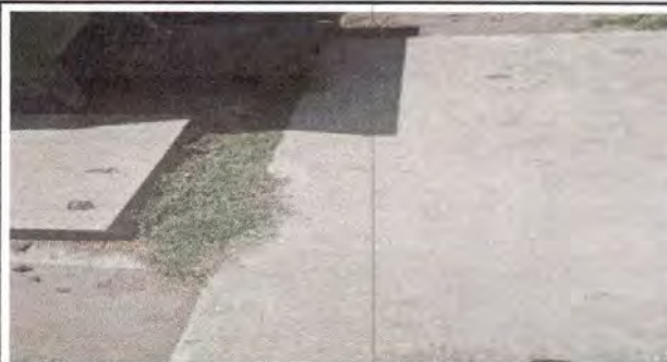
Foto 8: Sustrucción piso torta de concreto AREA PARA PILA
