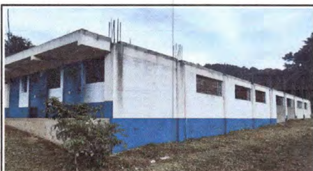
Foto 4: Pintura en muros exteriores e interiores
