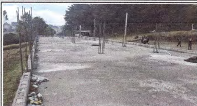
Foto 1: Impermeabilización de losa.
