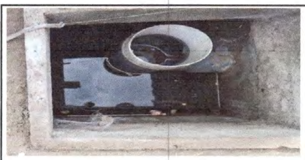
Foto 6: Limpieza de fosa séptica
