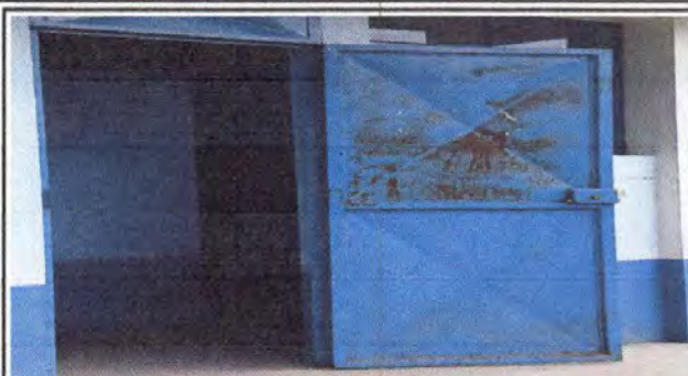
Foto 2: Mantenimiento a estructura (lijado, cambio de tubo, sujeciones, aplicación de pintura)
