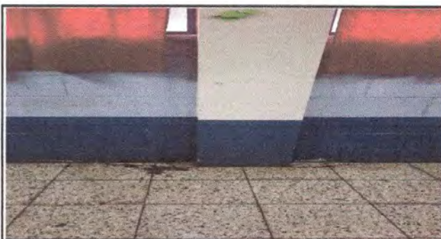
Foto 3: Sustitución piso granito por piso cerámico
